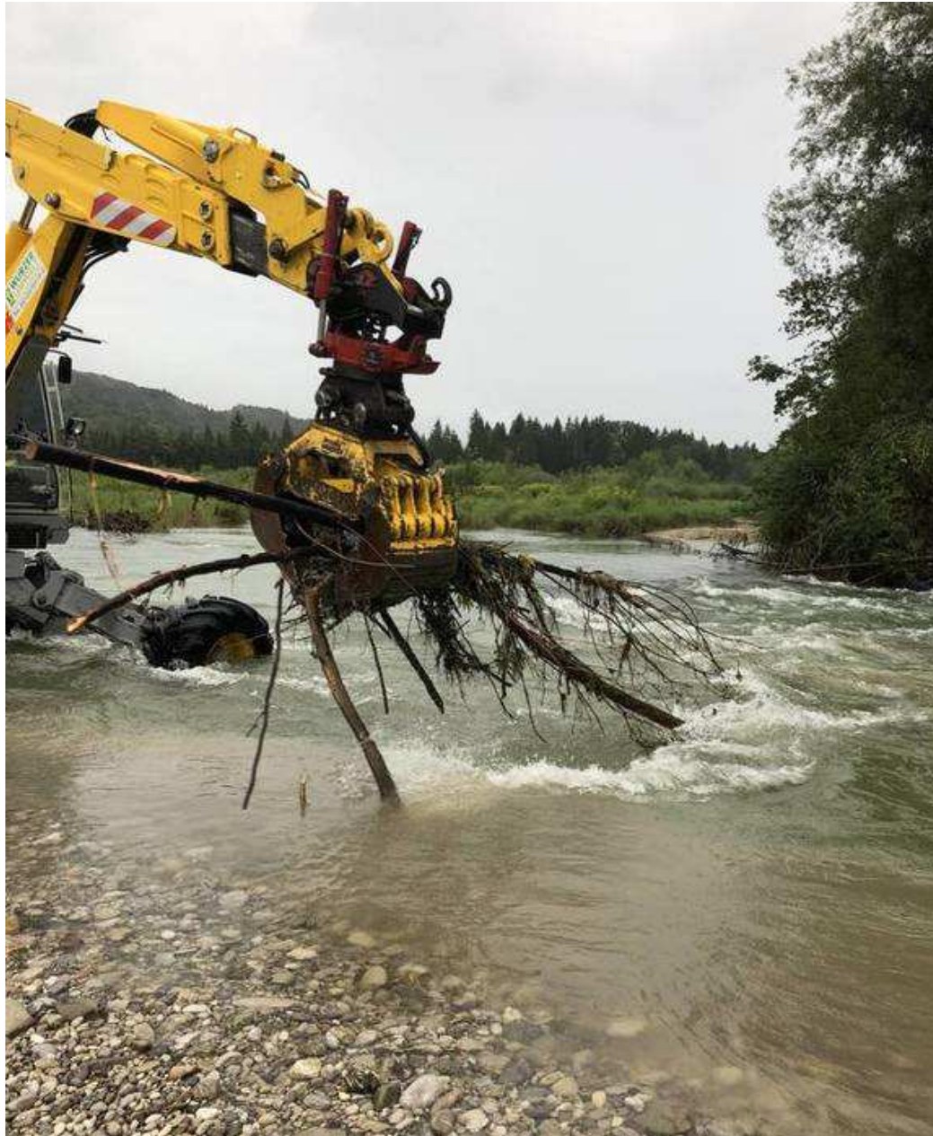
Der Schreitbagger bei der Arbeit. Foto: landratsamt
